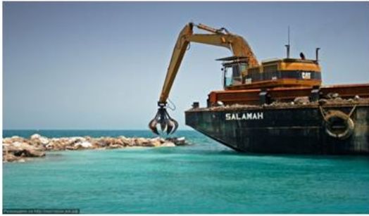
Рис. 8. Создание острова традиционным методом (отсыпка)
