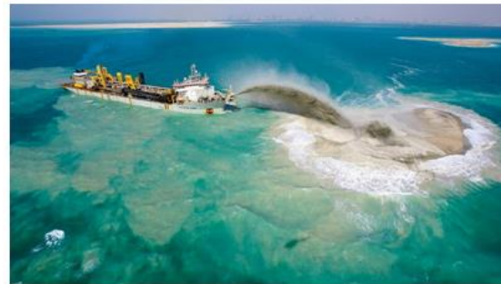
Рис. 11. Создание искусственного острова методом гидронамыв
