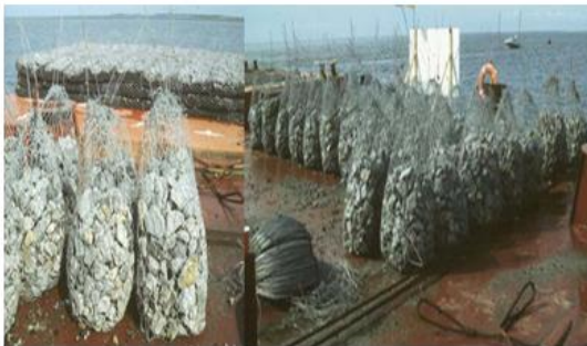
Рис. 10. Создание искусственного острова габионным методом
