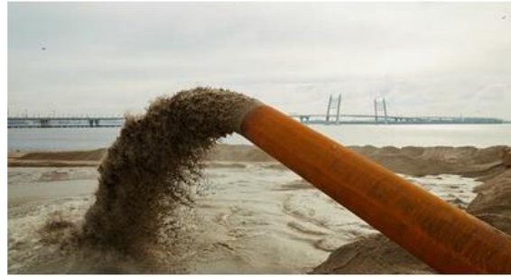
Рис. 9. Создание искусственного острова вулканическим методом
